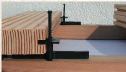
Systemteil in die Nut der Holdiele einsetzen. Schraube zum Fixieren etwas eindrehen.
