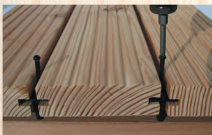
Dielen ansetzen, ausrichten, fixieren und mit der vorherigen Diele verschrauben. Schrauben nicht überdrehen, Nachjustieren jederzeit möglich.
