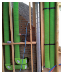
Uitbreiding woning Schipluiden
