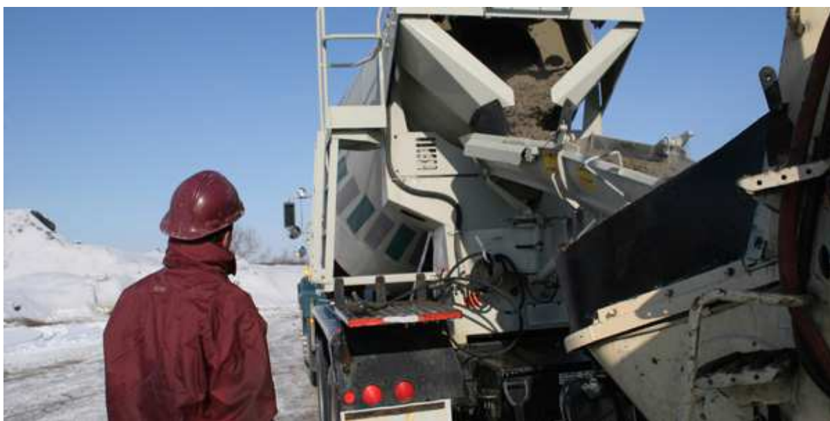
Beton storten in de winter kan als de juiste maatregelen worden getroffen. Foto: VOBN
