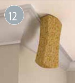
12 Entfernen Sie eventuelle Kleberreste sofort mit einem feuchten Schwamm. Kleine Oberflächenfehler können Sie ggf. ganz einfach mit Kleber ausgleichen. Lassen Sie alles 24 Std. trocknen.
