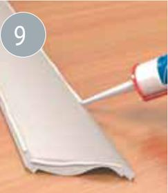
9 Gehen Sie wieder zum Ausgangspunkt zurück: Sie können jetzt an den 2 ebenen Flächen auf der Rückseite der Deckenleiste, d. h. an der Kontaktfläche mit der Wand bzw. Decke, vollflächig Kleber auftragen. Stellen Sie sicher, dass die Klebefläche sauber und staubfrei ist. Legen Sie die Deckenleiste an die Schlagschnurlinie an und drücken Sie sie leicht an, bis oben und unten überschüssiger Kleber austritt. Halten Sie die Leiste kurze Zeit in Position.
