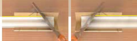
6 Legen Sie die Deckenleiste ordnungsgemäß ausgerichtet in die Gehrungslade ein und führen Sie den Schnitt wohlgemerkt am richtigen Ende aus.
