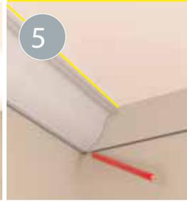
5 Beginnen Sie mit einer Innenecke: Positionieren Sie die Deckenleiste und zeichnen Sie mit Bleistift den Gehrungswinkel an.
