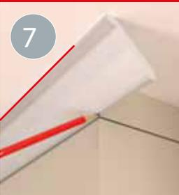
7 Legen Sie die nächste Deckenleiste stumpf anschließend an und markieren Sie mit Bleistift die Schnittlinie für den Außenwinkel.
