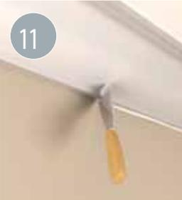
11 Ziehen Sie überschüssigen Kleber an Wand und Decke mit Hilfe einer Spachtel ab
