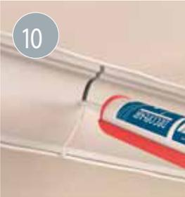
10 Bestreichen Sie die nächste Deckenleiste einschließlich der Enden mit Kleber, um sie stumpf anschließend auf gleiche Weise zu verkleben. Sehen Sie an den einzelnen Übergängen eine  $\pm 2$  mm breite und mit Kleber aufgefüllte Dehnfuge vor. Streichen Sie überständigen Kleber mit dem Finger oder einer Spachtel glatt.
