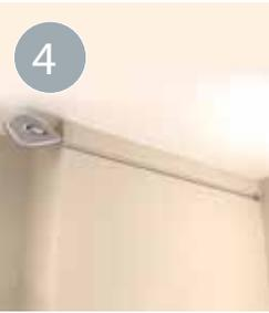
4 Markieren Sie mit der Schlagschnur umlaufend an den Wänden eine Linie für die Unterkante der Deckenleiste. Sie dient als Anhaltspunkt für die spätere Montage.
