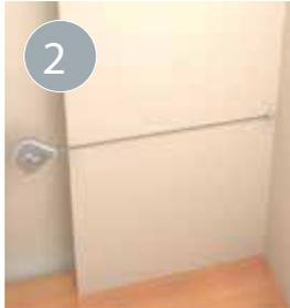
2 Markieren Sie mit der Schlagschnur umlaufend an den Wänden eine Linie für die Unterkante der Wandleiste. Sie dient als Anhaltspunkt für die spätere Montage.
