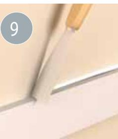
9 Ziehen Sie überschüssigen Kleber an der Ober- und Unterseite der Wandleiste mit Hilfe einer Spachtel ab.
