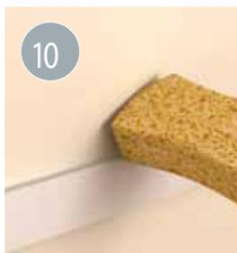
10 Entfernen Sie eventuelle Kleberreste sofort mit einem feuchten Schwamm. Kleine Oberflächenfehler können Sie ggf. ganz einfach mit Kleber ausgleichen. Lassen Sie alles 24 Std. trocknen.
