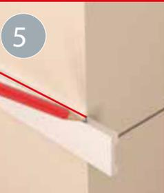
5 Wiederholen Sie diese Schritte mit der nächsten Wandleiste: Markieren Sie die Schnittlinie für den Außenwinkel.
