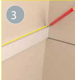
3 Beginnen Sie mit einer Innenecke: Setzen Sie die Wandleiste an und markieren Sie mit Bleistift den Gehrungswinkel.
