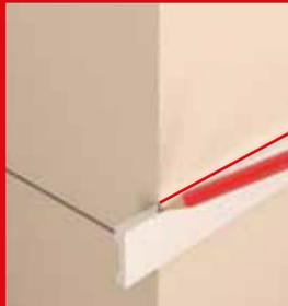
6 Markieren Sie die Schnittlinie für den Außenwinkel.
