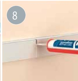
Bestreichen Sie die nächste Wandleiste einschließlich der Enden mit Kleber, um sie dann stumpf anschließend auf gleiche Weise zu verkleben. Sehen Sie an den einzelnen Übergängen eine  $\pm 2$  mm breite und mit Kleber aufgefüllte Dehnfuge vor. Streichen Sie überständigen Kleber mit dem Finger oder einer Spachtel glatt.
