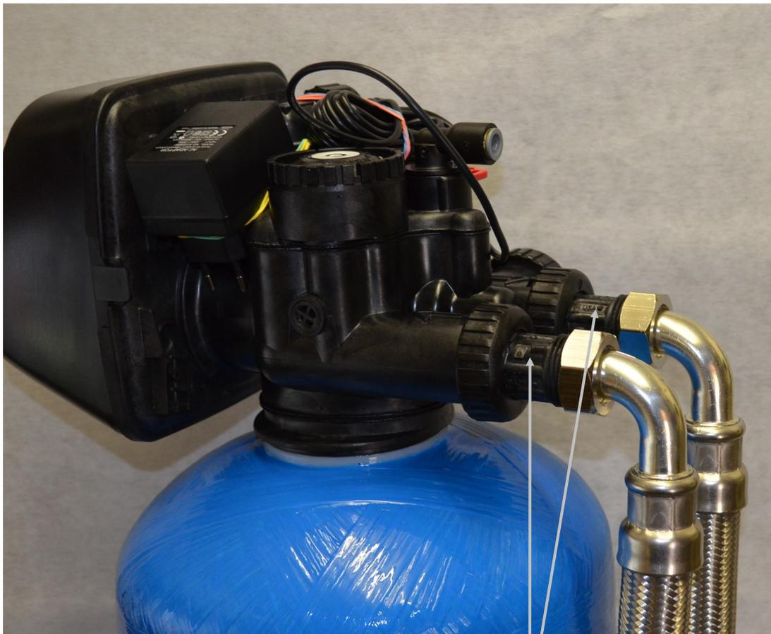
Beim Festziehen der Schläuche mit verstellbarem Maulschlüssel oder Rohrzange gegen halten
