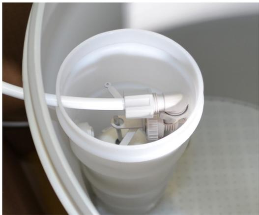
Soleschlauch bis zum Anschlag in das Anschlussstück einschieben und die Überwurfmutter festziehen
