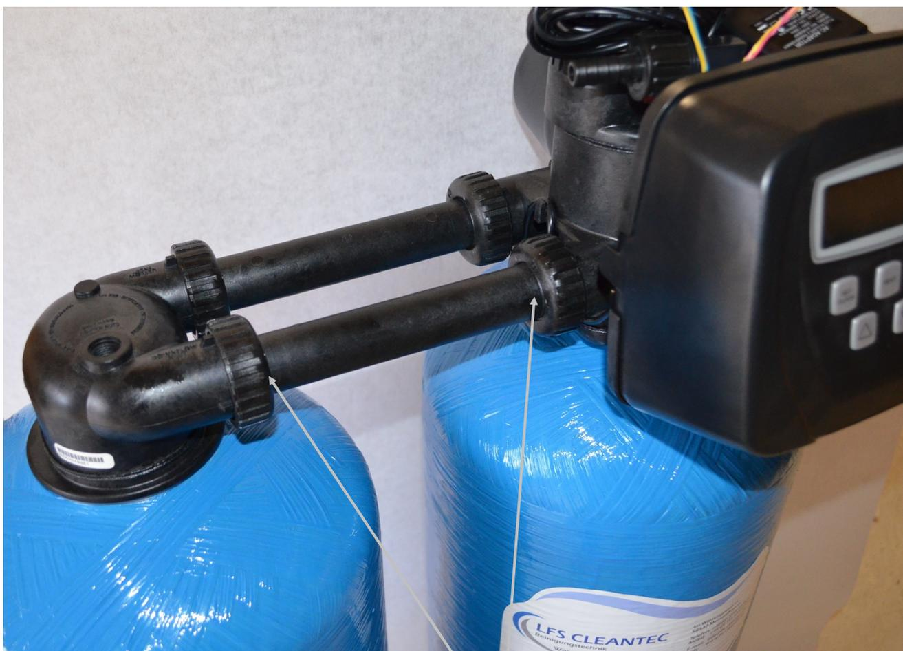
Verbindungsrohre in die Öffnungen am Steuerkopf und am Anschlussadapter einschieben. Die O-Ringe vorher leicht einfetten. Anschließend die Überwurfmuttern von Hand festziehen
