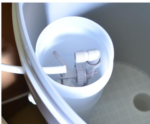
Den Soleschlauch von außen durch die Bohrung im Solebehälter und durch die Bohrung im Gehäuse des Schwimmerventils schieben
