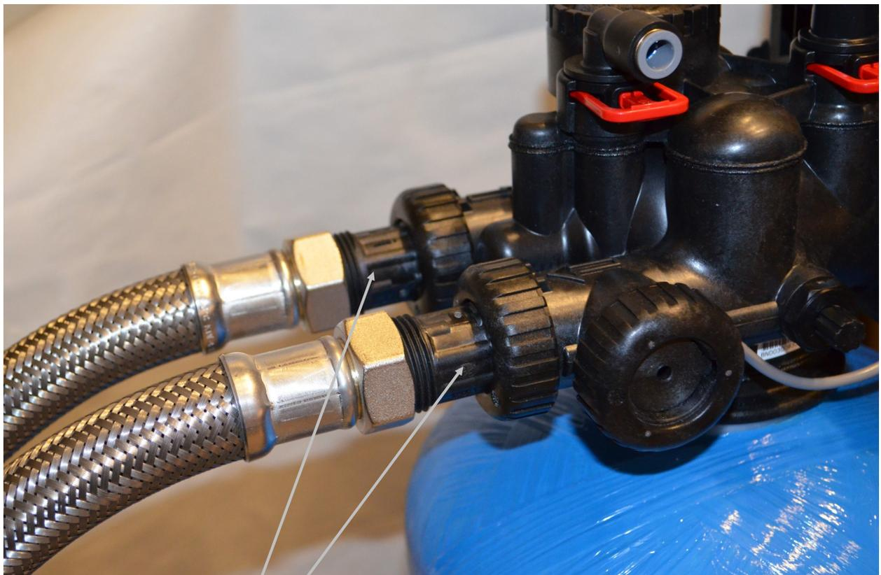
Beim Festziehen der Schläuche mit verstellbarem Maulschlüssel oder Rohrzanze gegen halten
