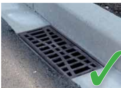
20 cm betonsteenstrek langs asfalt
