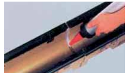
Veiligheidsvoeg (SF) opvullen met elastisch blijvende voegmassa.
