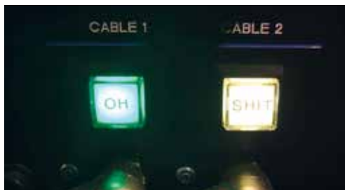
Mocht het draadloze systeem falen, dan kan met deze knoppen meteen overgeschakeld worden
