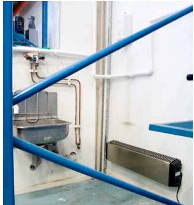
In het roestvrijstalen design is de Thermowarm bestand tegen corrosieve omgevingen.
