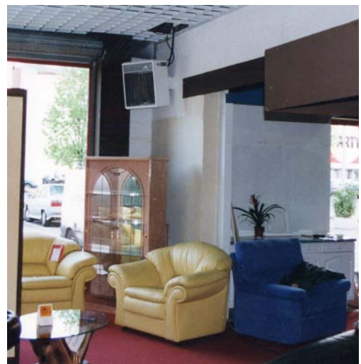
De Panther 20-30 luchtverhitter is geschikt voor het verwarmen van grote industriële panden.
