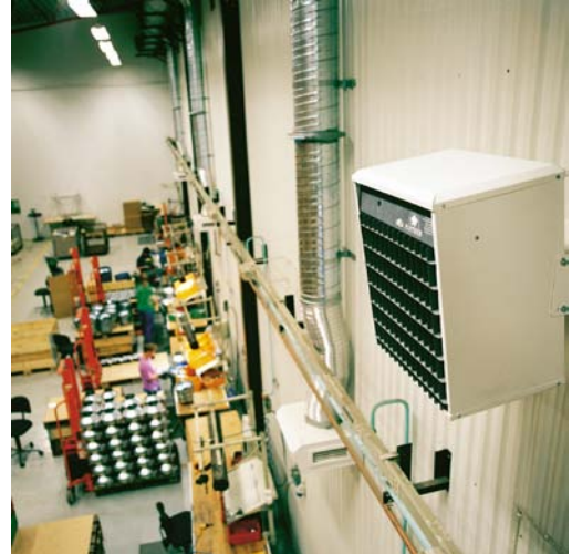
De Panther 20-30 luchtverhitter is geschikt voor het verwarmen van grote industriële panden.
