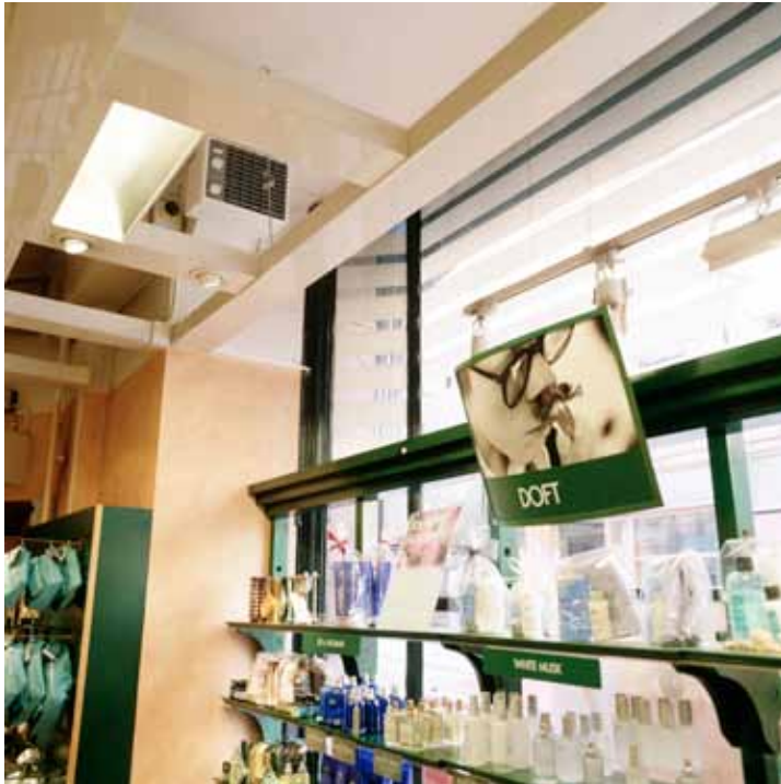
De Cat-luchtverhitter met mengkamer kan eenvoudig problemen met negatieve druk in ruimtes verhelpen. Koude lucht wordt van onder opgenomen, verwarmd en vervolgens afgegeven aan de ruimte.
