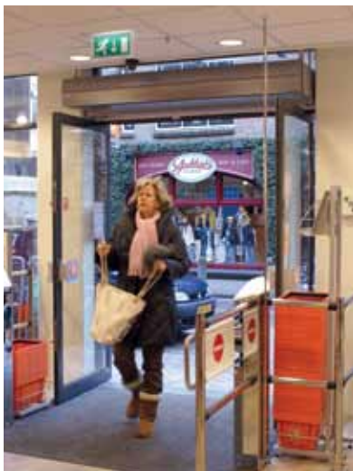
Het DoorFlow luchtgordijn boven de deuropening creëert een tochtvrij binnenklimaat.
