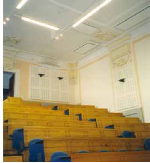
Montage aan het plafond beschermt Thermocassette tegen beschadiging.
