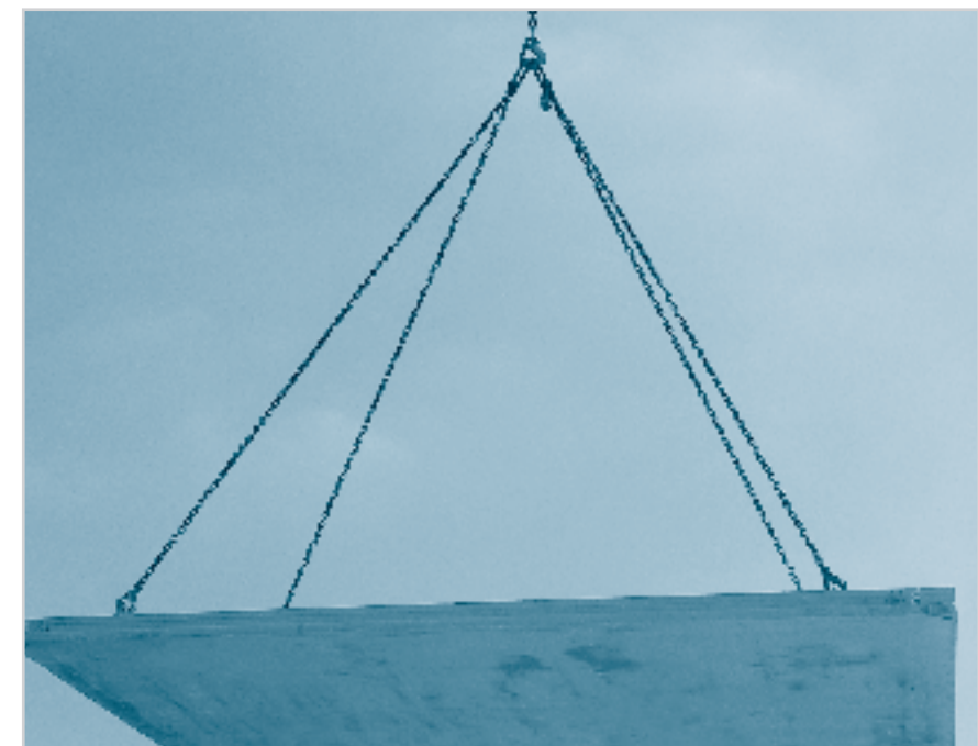
Hijsankers en hijsgereedschap voor vlakke platen
