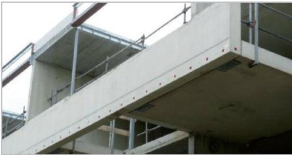
BEVESTIGING VAN BALKON BALUSTRADES
