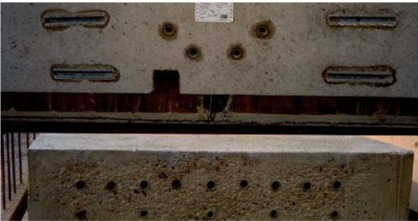
STELLEN EN BEVESTIGEN VAN PREFAB WANDELEMENTEN
