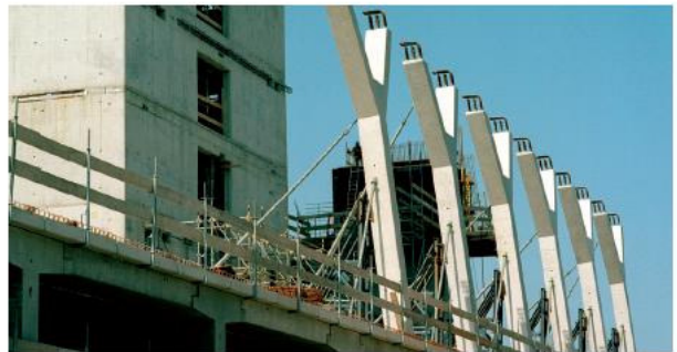
STELLEN EN BEVESTIGEN VAN PREFAB ELEMENTEN
