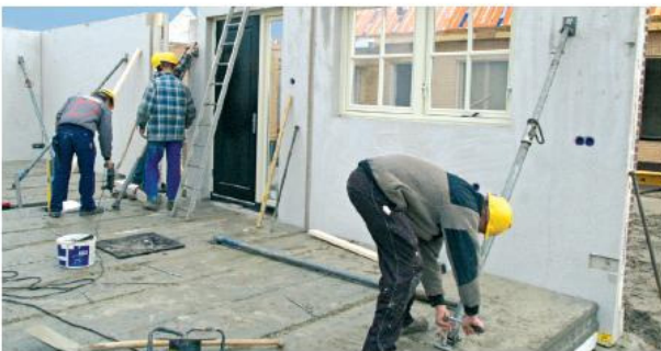
STELLEN EN BEVESTIGEN VAN PREFAB WANDELEMENTEN
