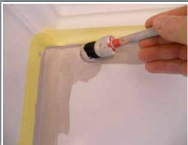
2 PLAATSING BETON PRIMER
